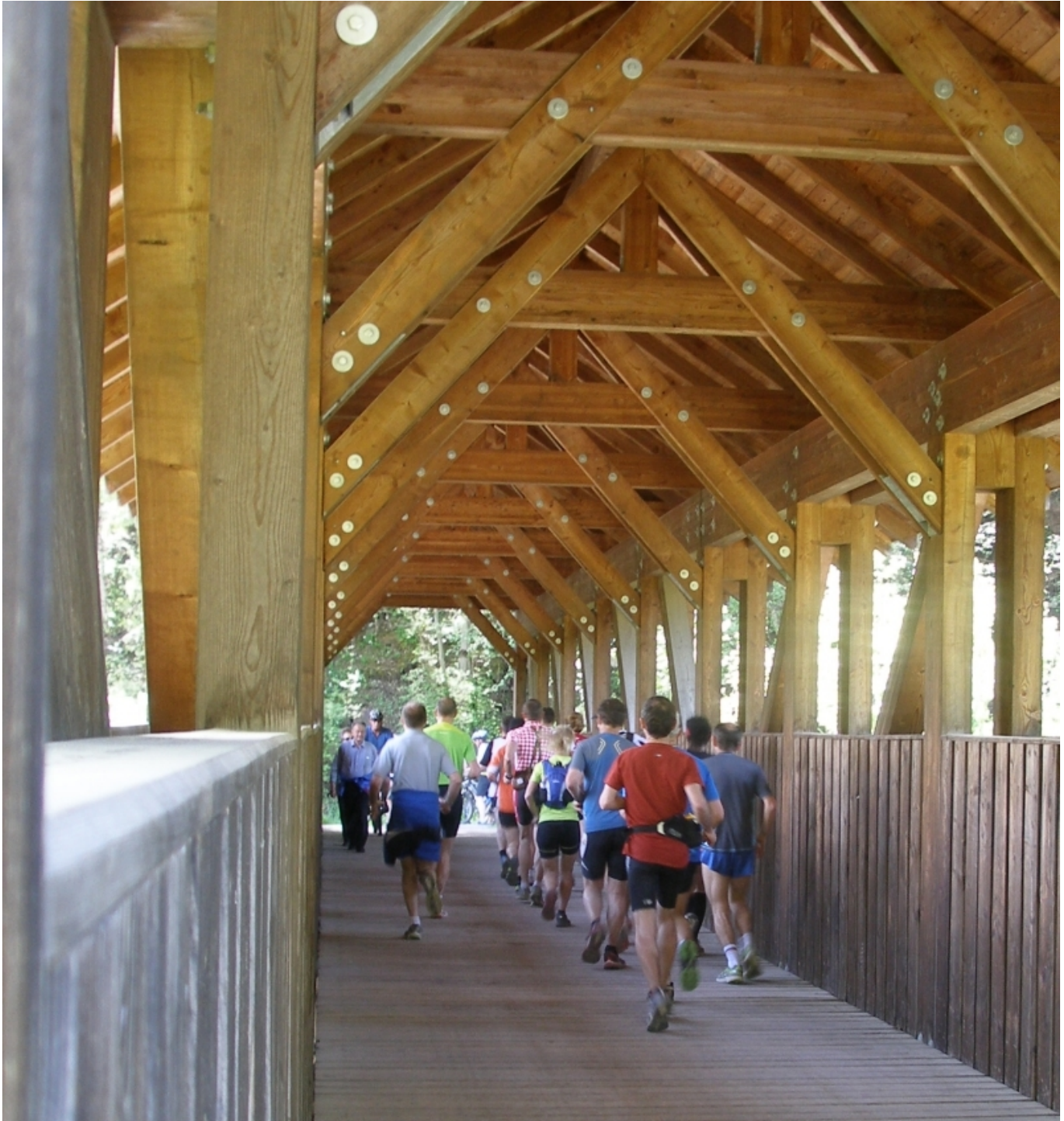
Eine der wenigen gedeckten Holzbrücken
